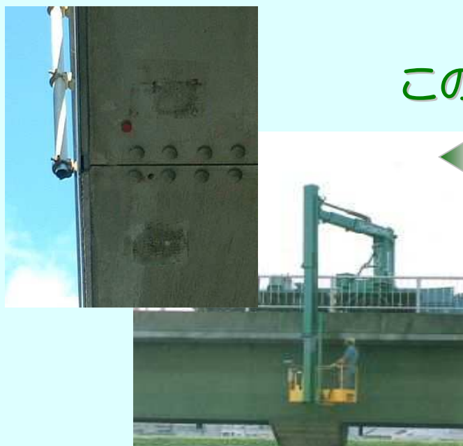
ゴム栓の設置、撤去状況
