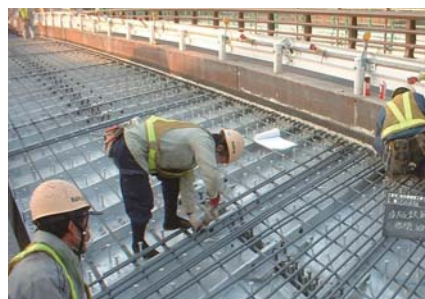
場所打ちタイプによる床版取替え
