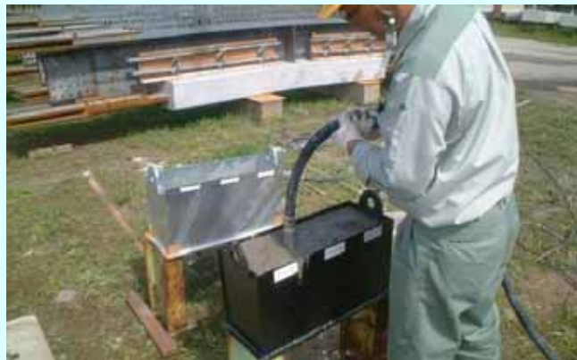
コンクリート打設・バイブレータ挿入状況
