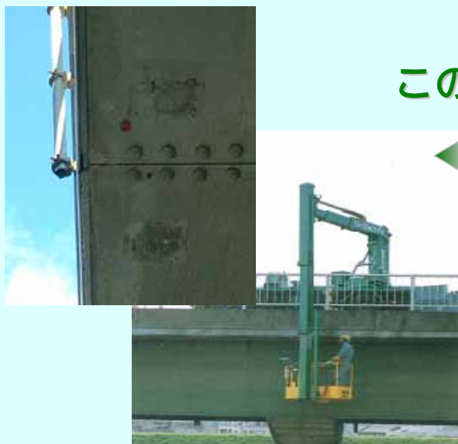
ゴム栓の設置、撤去状況
