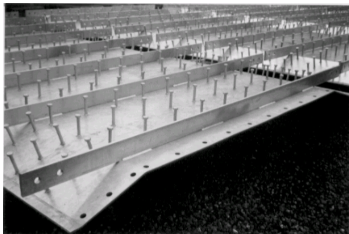
写真-3 鋼板と横リブとの断続溶接
